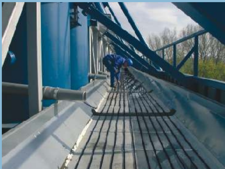
Przykład ułożenia przewodów grzewczych w korycie dachowym
